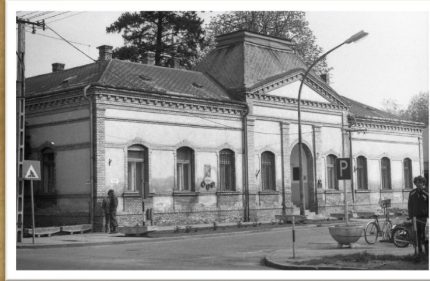
A volt községháza, 1985-ben. Homlokzatán a Tanácsköztársaság és a felszabadulás emléktáblája
